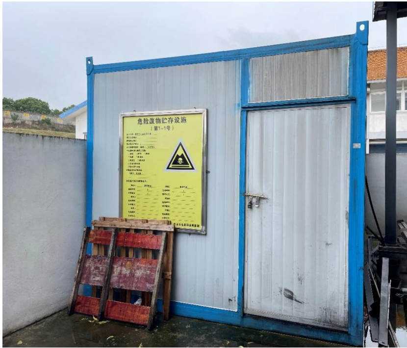
图 3-1 殡仪馆现有危废库现场情况
