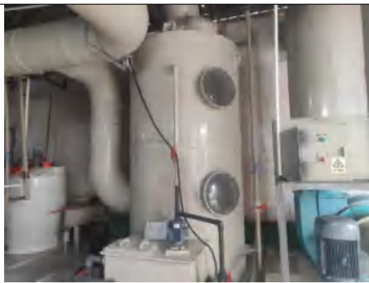
3#二级碱液喷淋+水喷淋装置
