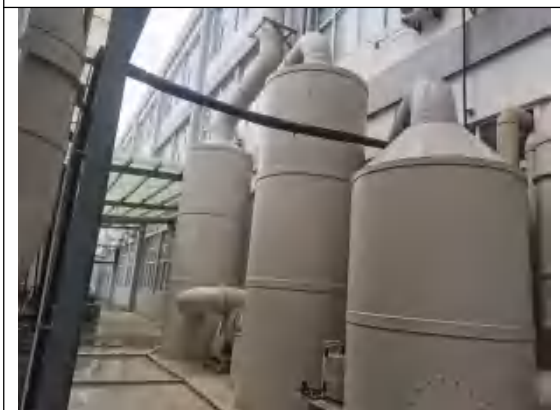
1#二级碱液喷淋+水喷淋装置
