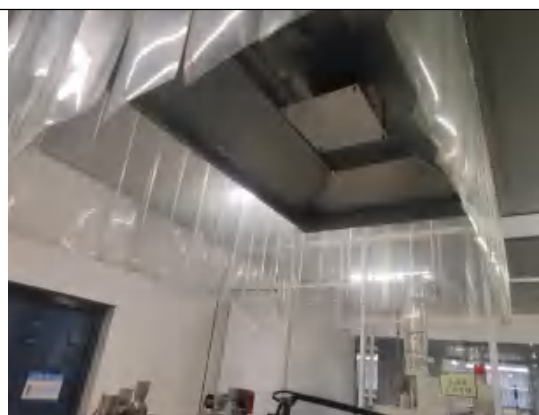
印刷工段集气罩
