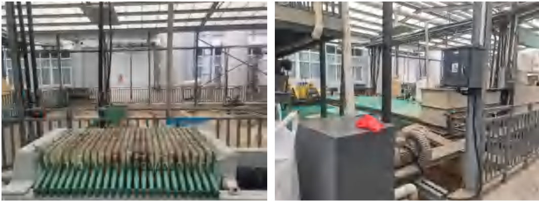
图 3-1 厂区污水处理站
