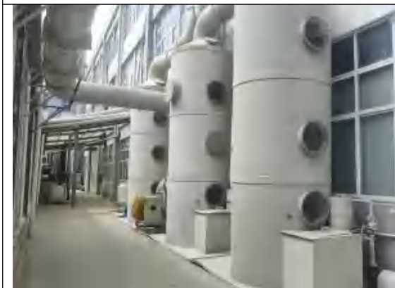
1#二级碱液喷淋+水喷淋装置
