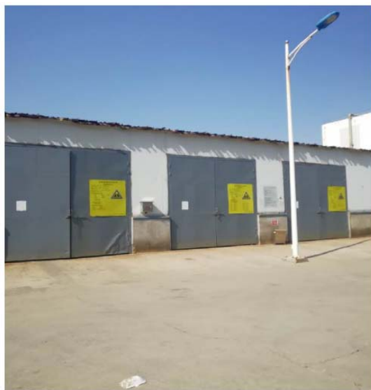
现有危废贮存设施标识牌
